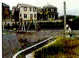
現況測量の実施
